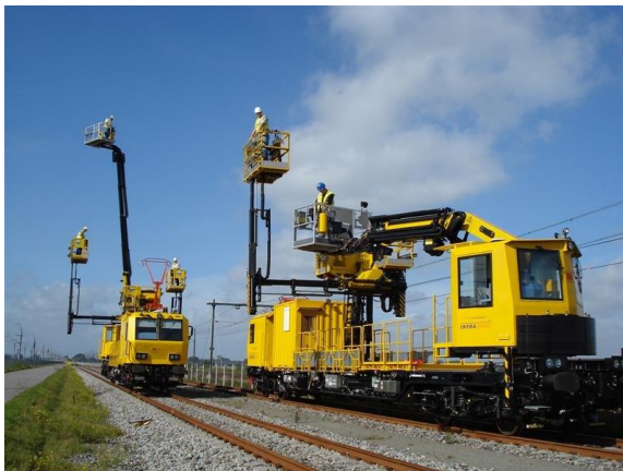
Slika 18: Dvižne ploščadi na železniških vozilih
