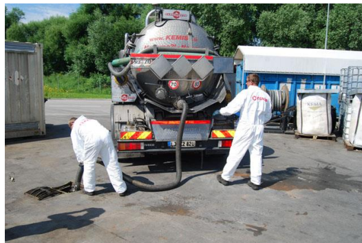
6. Iz kanala se izčrpa tekočino v cisterno
